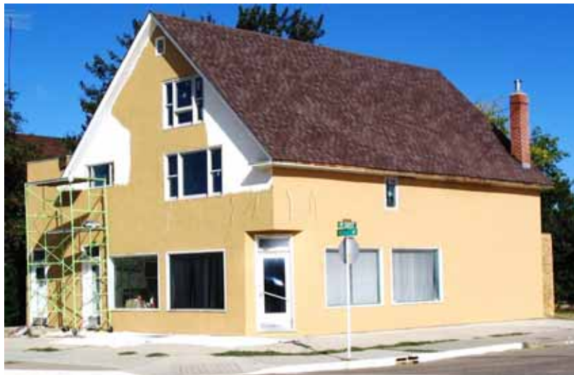
写真2 / ストリーの建物
